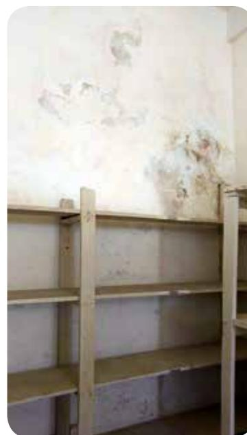
**Figura 3:** Paredes com manchas de mofo.
